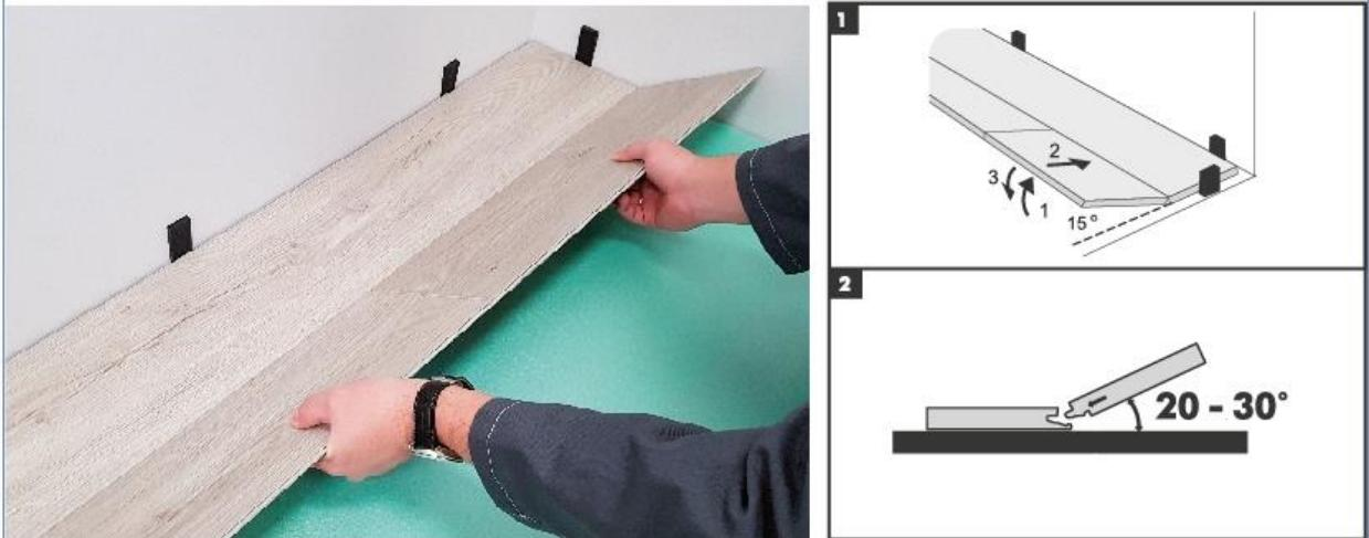
**5. Важно!** В помещениях площадью более 100м<sup>2</sup> необходимо предусмотреть деформационные зазоры не менее 10мм. Длина непрерывного ряда не более 10м в длину и 10м в ширину. **Межкомнатами обязательно нужны пороги! В дверных проемах необходимо оставлять деформационные зазоры не менее 10мм.** После монтажа деформационные зазоры закрываются специальными накладными порогами. (Схема 5).
