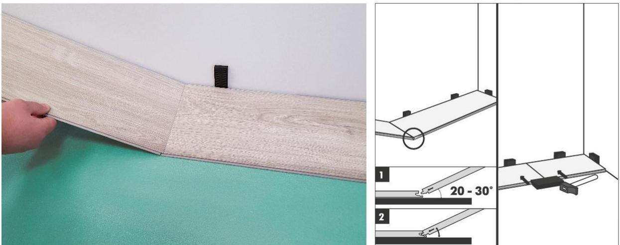
**3.** Продолжайте соединять первый ряд, пока не дойдете до последней целой панели. Установите последнюю панель, повернув на 180 градусов рисунком вверх. Измеряйте и отмечайте, затем, используя линейку и универсальный нож, прорезайте панель по линии отметки и отламывайте.
