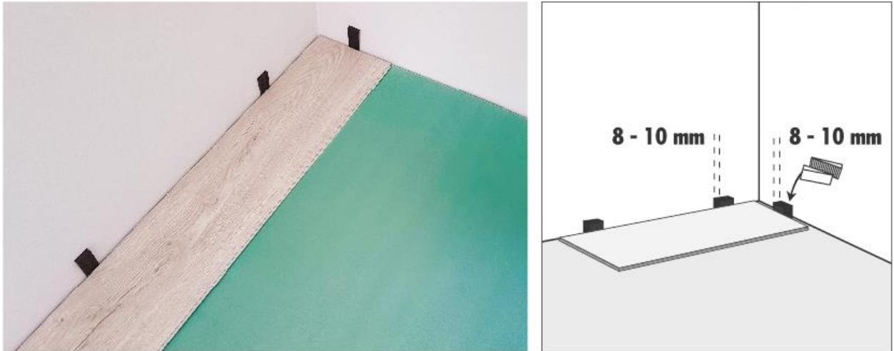
**2.** В паз торцевой стороны первой панели вставьте шип следующей панели под углом примерно 20-30 градусов. Опускайте панель, запирая замок. (Схема 2).
